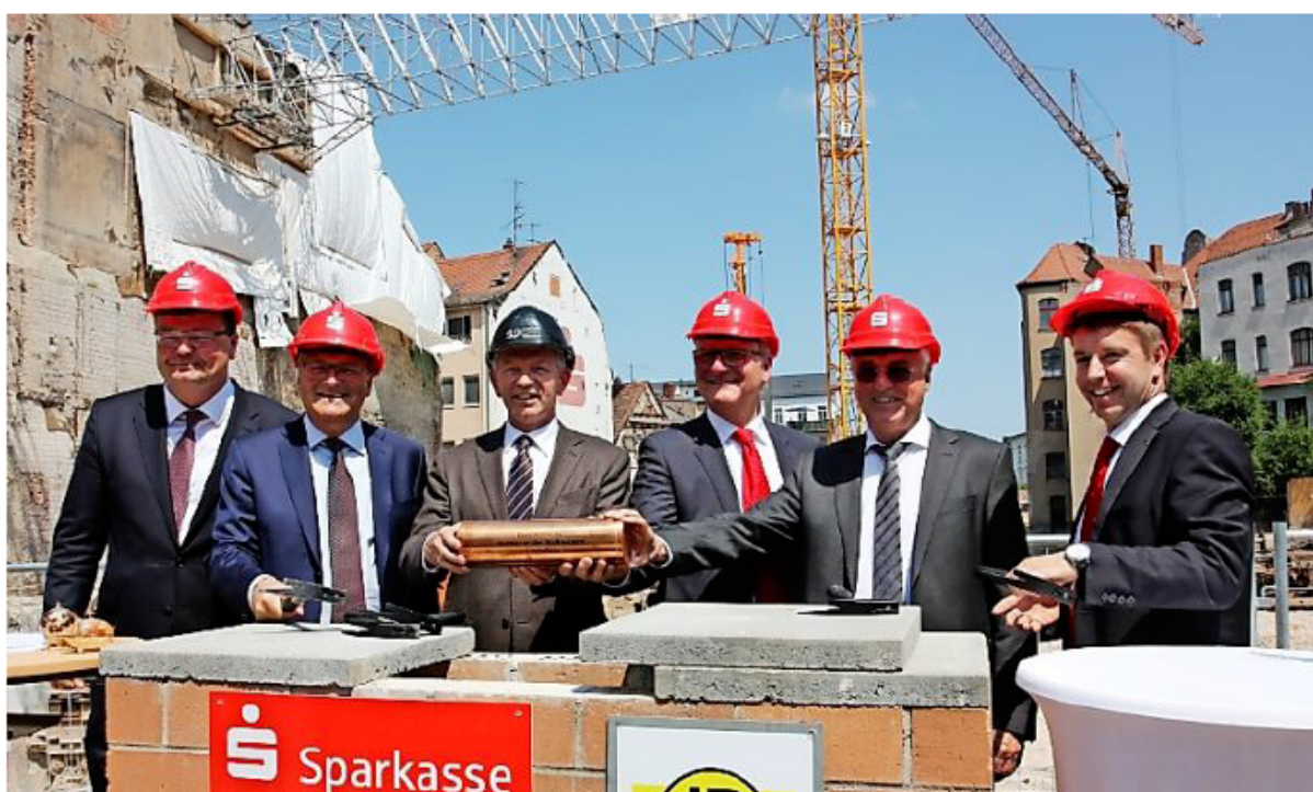
Gut „behütet“ versenkten die Verantwortlichen die gefüllte Zeitkapsel in den Grundstein.
